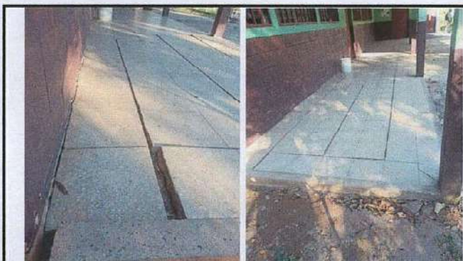
FOTO 3: SUSTITUCIÓN DE PISO DE GRANITO EN CORREDOR
