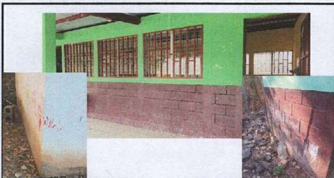
FOTO 5: PINTURA EN MUROS
