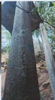
FOTO 9: REFUERZO DE BASES DE COLUMNA DE CONCRETO PARA LOSA QUE SOSTIENE EL TINACO
