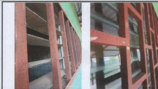
FOTO 2: MANTENIMIENTO DE BALCONES DE METAL EN AULAS Y COCINA
