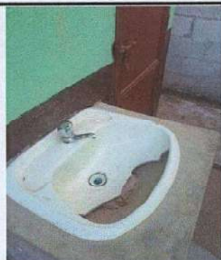
FOTO 7: SUSTITUCIÓN DE 1 LAVAMANOS QUEBRADO Y REPARACIÓN DE 1 LAVAMANOS EN MAL ESTADO
