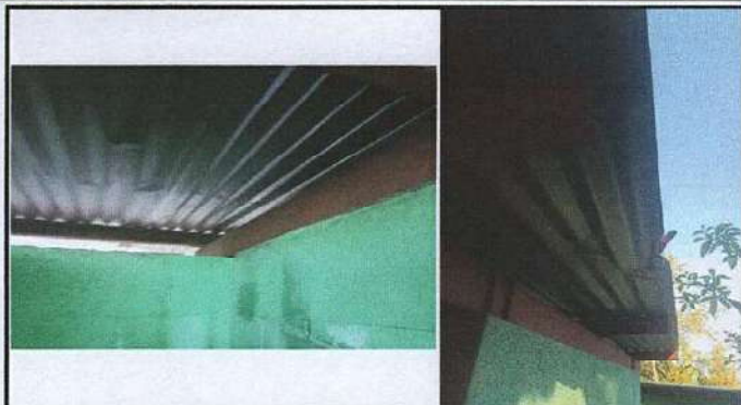
FOTO 1: SUSTITUCIÓN DE TECHO EN SERVICIOS SANITARIOS
