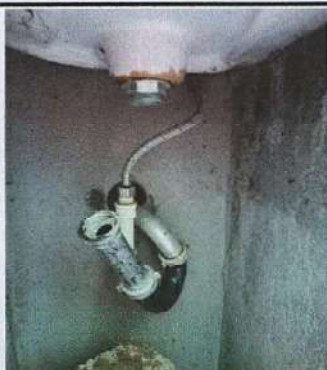
FOTO 7: SUSTITUCIÓN DE 1 LAVAMANOS QUEBRADO Y REPARACIÓN DE 1 LAVAMANOS EN MAL ESTADO
