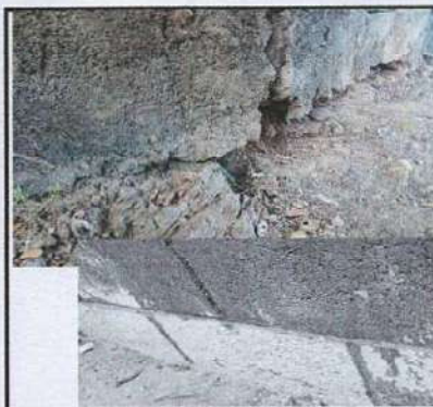
FOTO 10: REFUERZO Y REPARACIÓN DE MURO DE CONTENCIÓN PERIMETRAL
